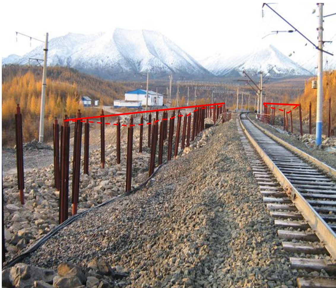
Рис.11. Фото 7. Мост на км 1374 пк 2+12 со скальной конструкцией и СОУ. Высота охлаждающей скальной бермы и балластной призмы около 3-х м. Октябрь 2008 г
