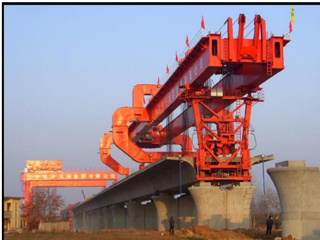
Рис. 2. Общий вид консольно-шлюзового агрегата (КША)
